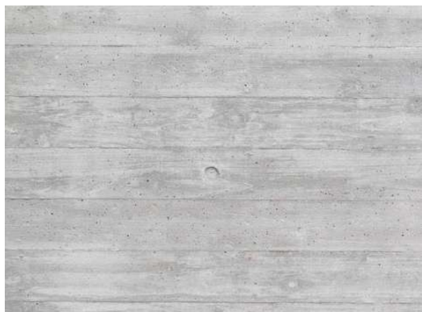
BETON SZALUNKOWY _ SUFITY
